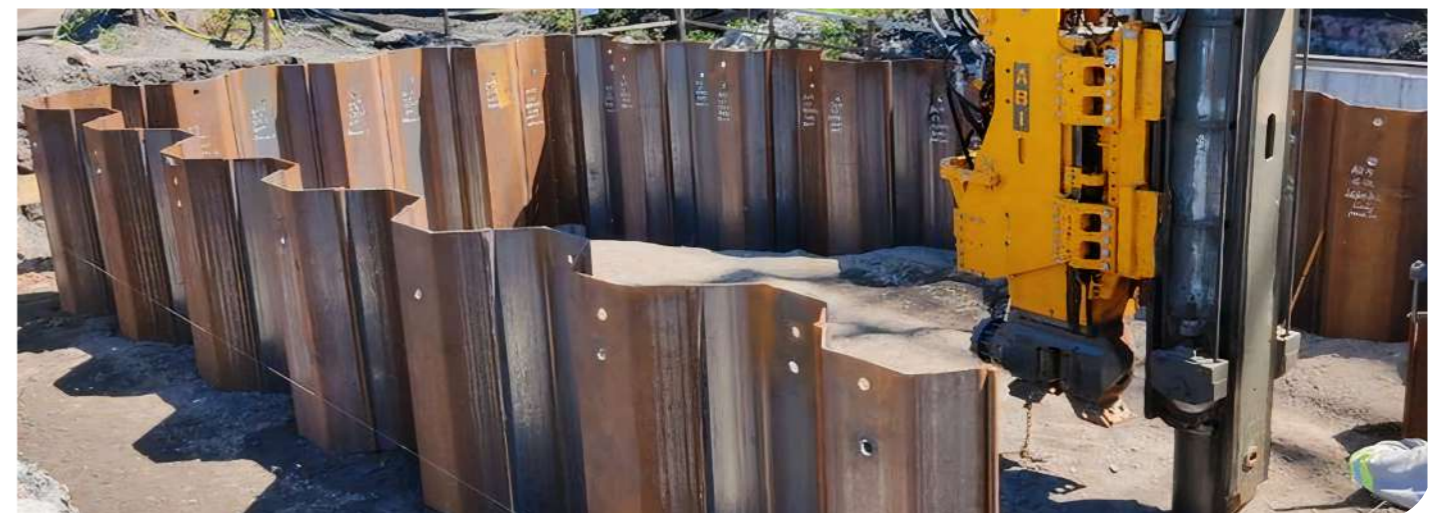
Drenagem - Pátio de estocagem Local: Serra, ES Produto: GU™
