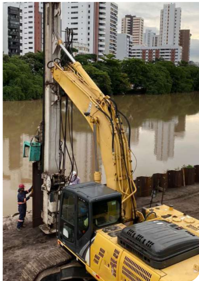
Martelo vibratório montado em equipamento com torre guia Local: Rio Capibaribe, PE
