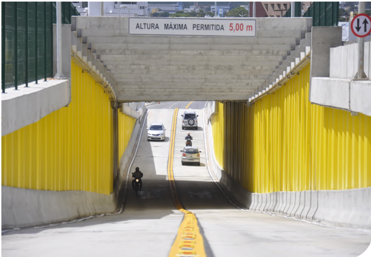
Complexo Viário Arena das Dunas Local: Natal, RN Produtos: AU 14™/ AZ ® 19-700
