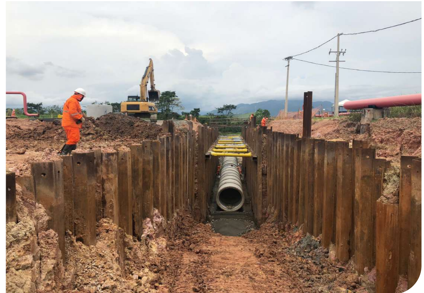
Escoramento de Vala Local: Itaboraí, RJ
