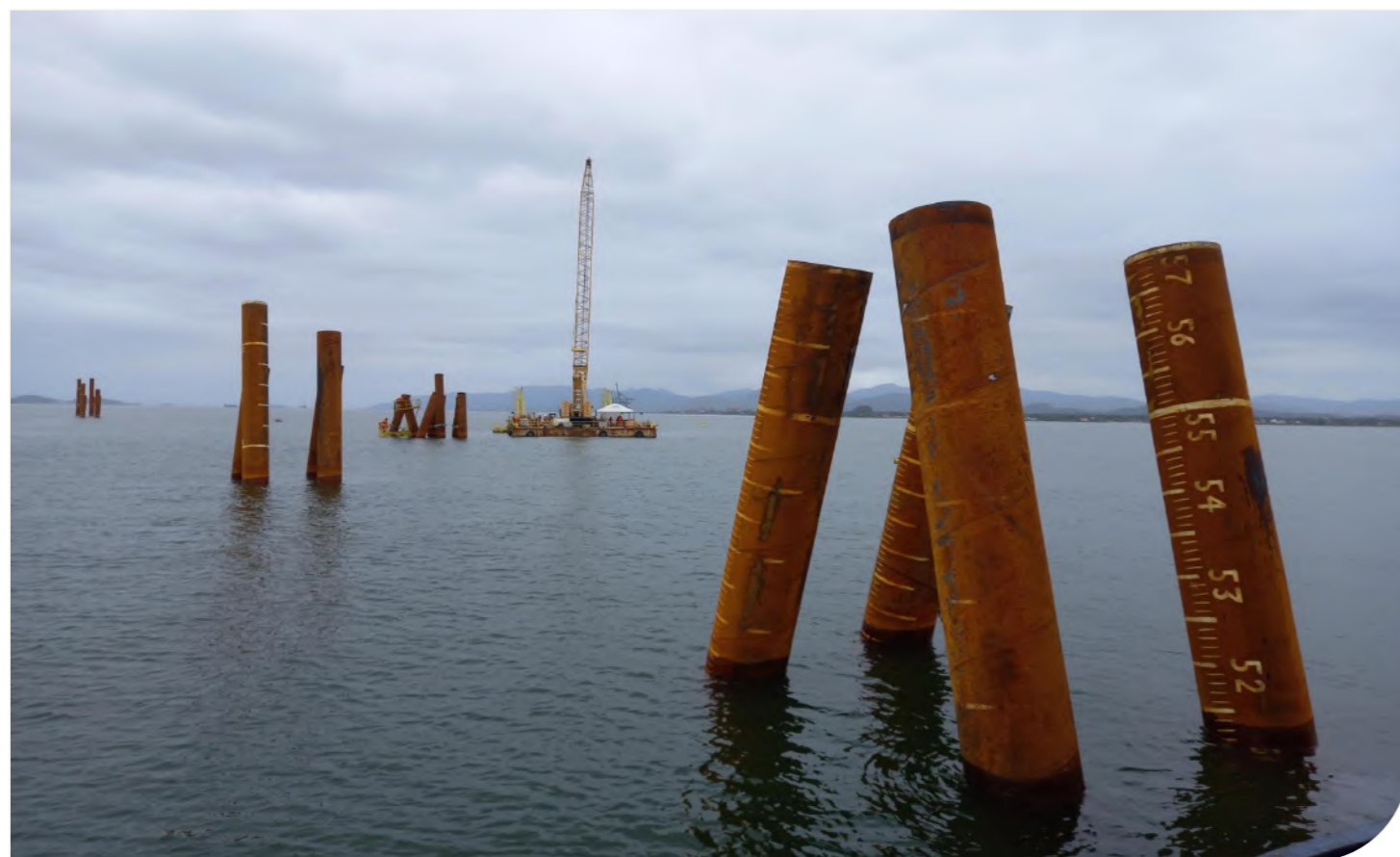
Terminal de Gás Local: São Francisco do Sul, SC Produto: Tubos com solda helicoidal
