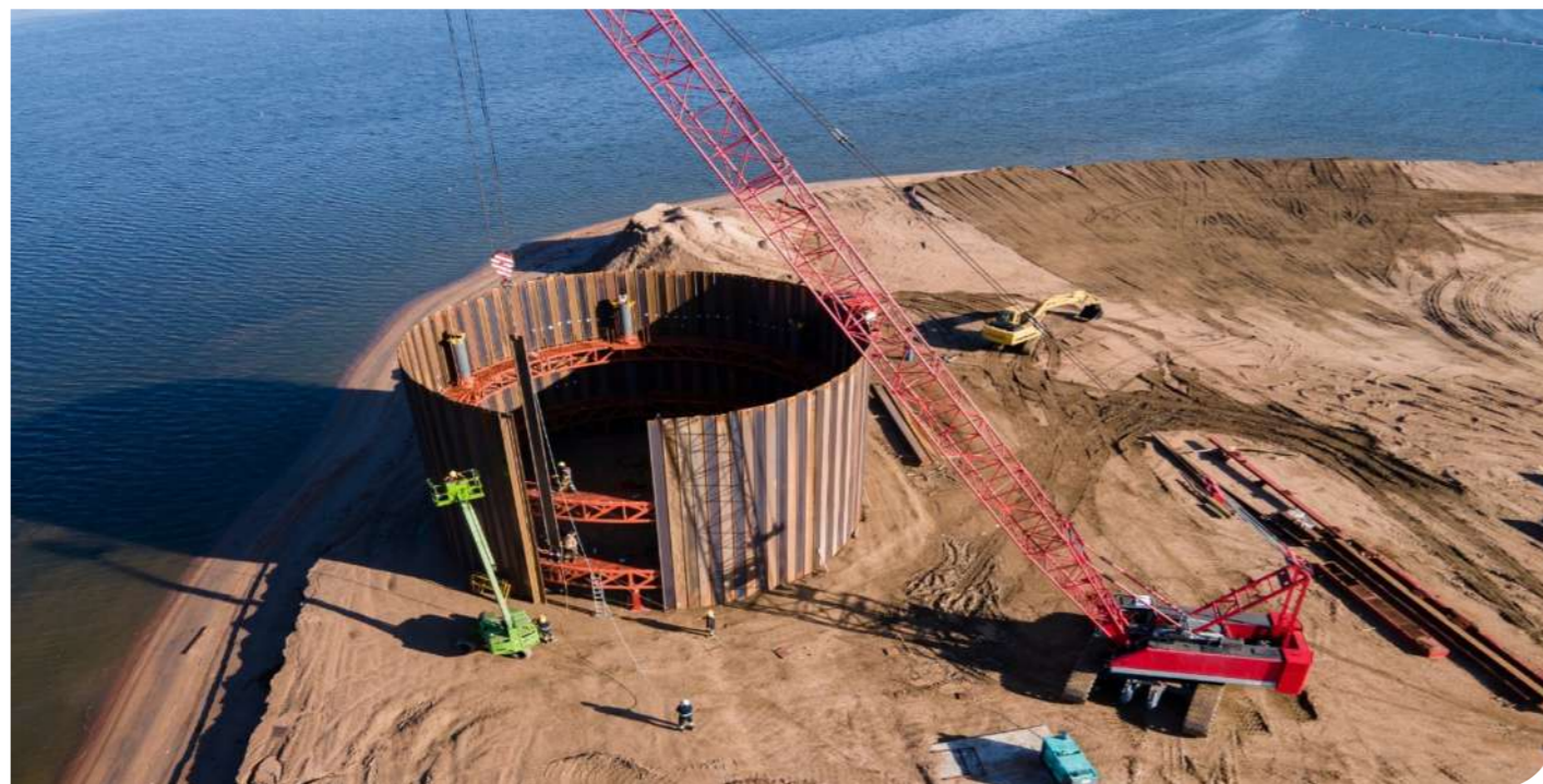
Porto Capurro Local: Montevideú, Uruguai Produtos: Estacas Pranchas Planas AS 500
